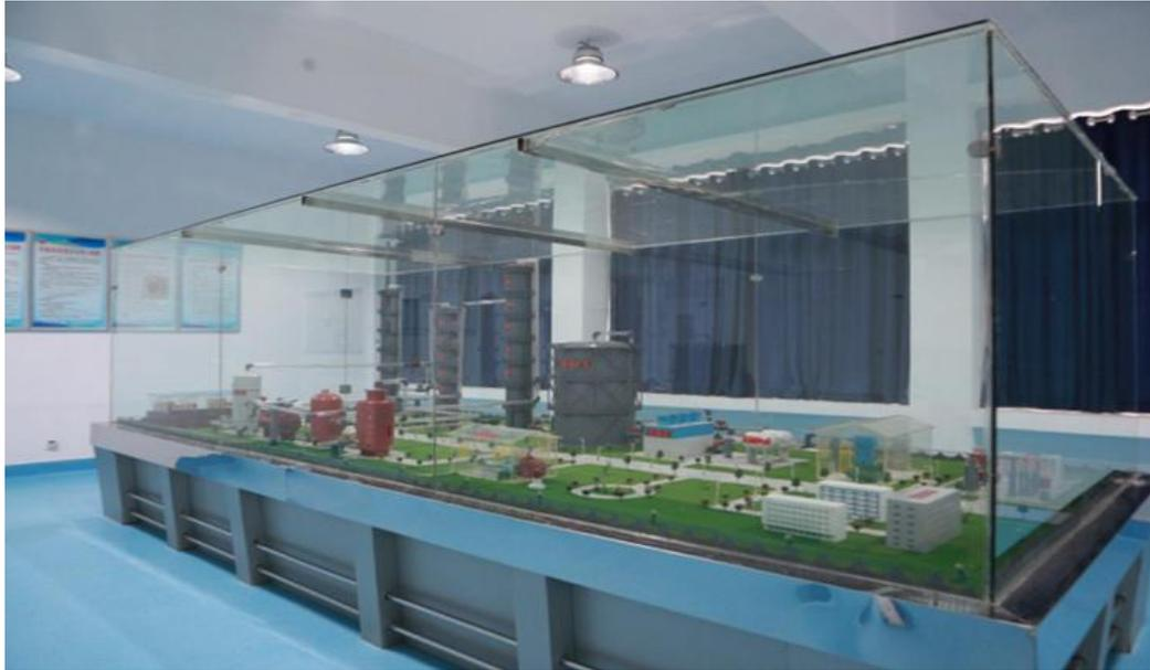
该实训室根据真实化工企业布局为原型，开发的可视化立体化工厂布局。在这里可以形象直观地了解化工企业的布局和构成，一个化工生产区一般包括生产车间、辅助车间、辅助设施和办公生活设施，通常由主干道将工厂区分为几片布置区域，安排布置车间和辅助设施。车间一般按照大流程顺序进行排布，尽可能满足工艺要求，安全且美观，辅助设施中的库房要靠近主干道，便于输入和输出，循环水冷却装置，应设置在通风的开阔地带，办公楼、食堂等一般设置在厂区大门边，处于生产区的上风向，通常管线的布置采用平直辐射，与道路、建筑、管线之间互相平行，或直角交叉。有利于学员对企业的整体布局与有效优化，提出建设性的意见。
