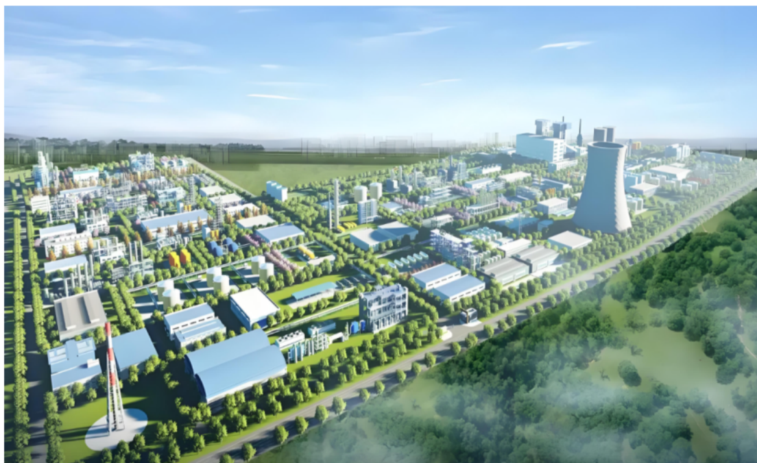
图 1-3 千亿级氟硅新材料项目
