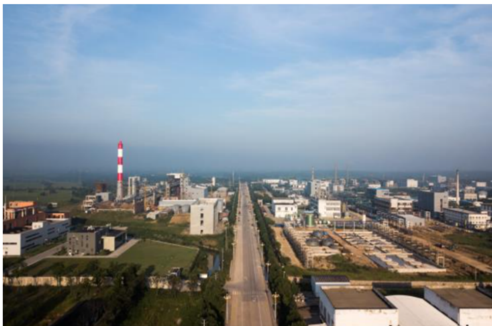
图 1-1 安徽广信农化广德厂区生产区
